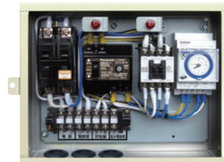
電機式電熱輔助器主控制箱 室外
